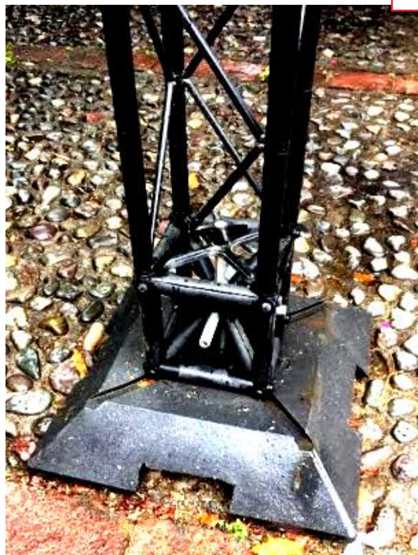
APOYO BASAL TIPO PILAR TRUSS A SUELO
